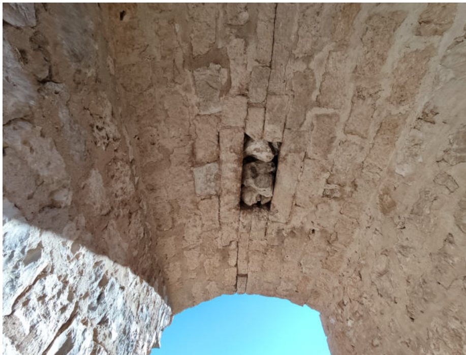
Vista de la bóveda de cantería de cañón rebajado en donde se abre la buhera. Actualmente está colmatada por escombros
