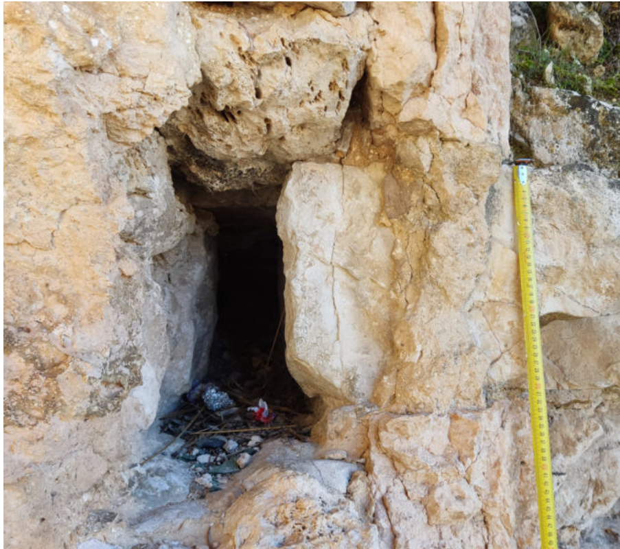
Detalle del hueco del tranco conservado en el muro
